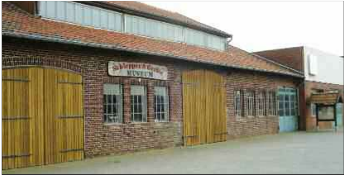
Vorderansicht Schmelze und Landmaschinen-Reparatur, heute ist hier das Schlepper & Geräte Museum untergebracht
